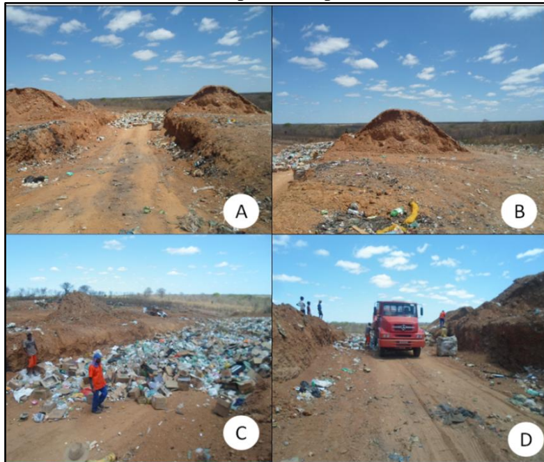
Figura 3 - Disposição dos resíduos sólidos urbanos no Município de Serrita-PE. A. Entrada da vala de deposição; B. Material oriundo do solo retirado das trincheiras e que é utilizado para cobertura dos resíduos; C. Resíduos para serem compactados; D. Veículo utilizado para transporte do resíduo.
